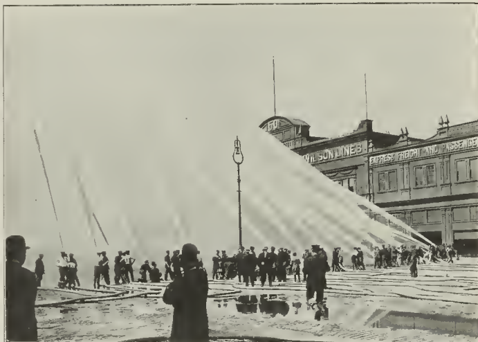
Bomba de incendios de alta presión recientemente instalada en Nueva York (De fotografía de Carlos Delius.)
